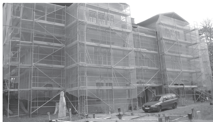
Būvlaukumā notiek sagatavošanās koka ēkas fasādes un tās būvdetaļu restaurācijai.
