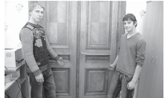
Armīnam Pilskungam un Janekam Beļēvičam, kuri mācās par galdnieka palīgiem, durvju atjaunošana ir ļoti laba skola. Lai durvis atjaunotu pēc oriģināla, nepieciešams ilgs laiks, jo tās ir salauztas, stiklotas, kas vēsturiski nav bijis, nonaglotas, bez daudzām detaļām.
