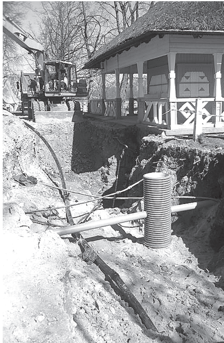
Līdzīgi kā pērn tika būvēts ūdensvads un kanalizācijas tīkli Pils ielā (attēlā) šovasar ekskavatori rosīsies Liepājas ielā, jo Kuldīgas dome uzsāks pilsētas ūdenssaimniecības modernizāciju par vairāk nekā 9 miljoniem latu.
